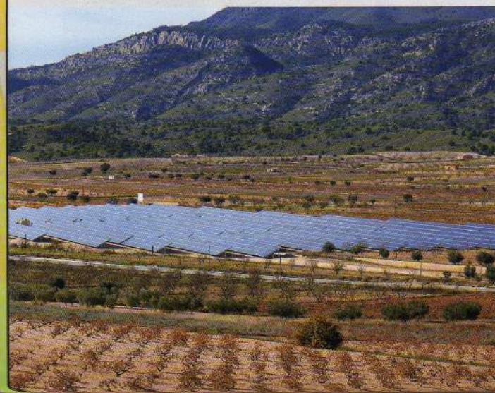
PLANTA FOTOVOLTAICA UBICADA EN LA ALBERQUILLA
